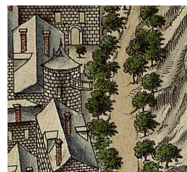
Une tour ronde avec passerelle
